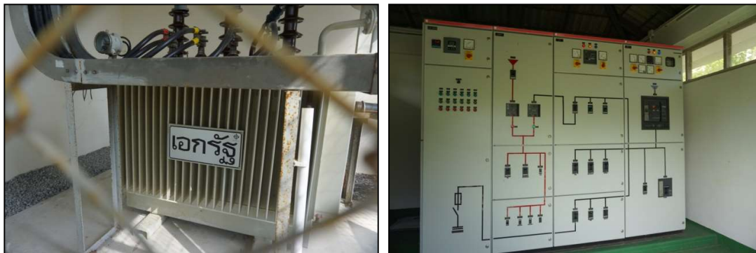
ภาพที่ 1-9 หม้อแปลงไฟฟ้าหลักและแผงจ่ายไฟฟ้าหลักของโครงการฯ
